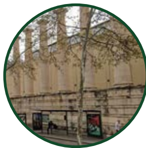
Recinte tancat i façanes cegues
